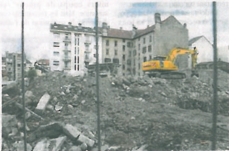
Le chantier a bien avancé. Le futur quartier accueillera plus de mille habitants d'ici à la fin de 2014. LUCIEN FORTUNATI
